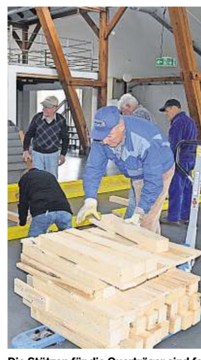
Die Stützen für die Querträger sind fertig und werden gleich angeschraubt.
