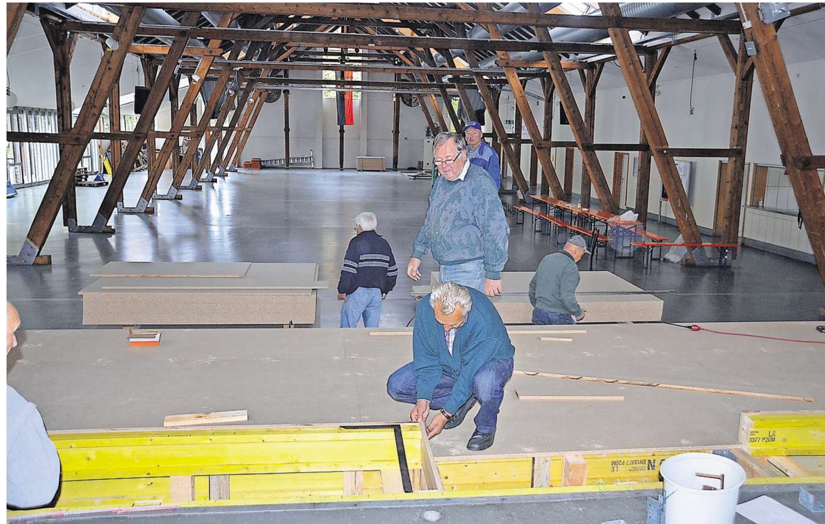
Auf den gelben Querträgern wurden 22 Millimeter starke, nagelneue Spanplatten verlegt. Einige davon wurden mit Feinarbeit beim Sägen passend gemacht. Alois Hörteis schaut hier Alois Bierschneider beim Ausmessen zu.
